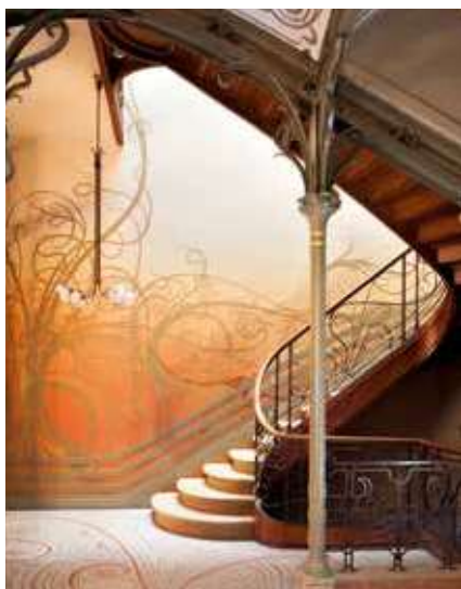
Hôtel Tassel, Bruxelles (B), Victor Horta, 1893-1894. L'escalier Art nouveau en fonte, décoré d'éléments floraux, devient partie intégrante de l'architecture. Structure, ornement, lumière, couleur se fondent pour ne faire qu'un.
